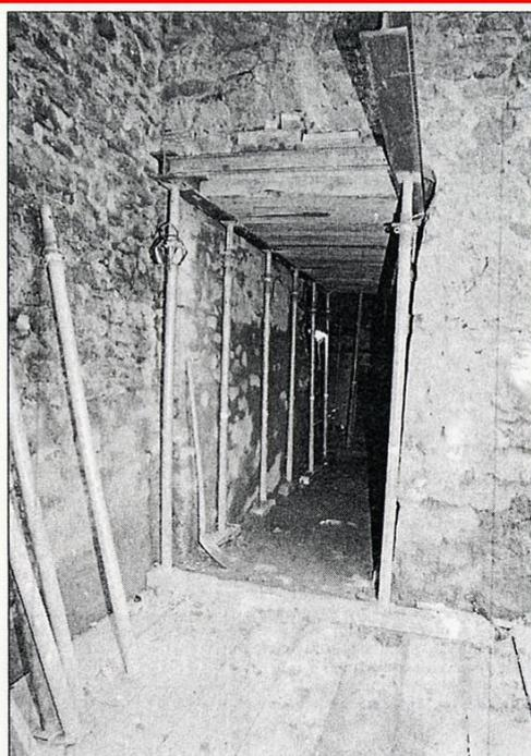
**Rundum abgesichert:** Mit dem Einsatz einer Spezialsäge ist es einem Fachunternehmen gelungen, den neuen Zugang zum erweiterten Burgkeller in Dreieichenhain durch das fast vier Meter dicke Mauerwerk zu treiben. Damit ist der Geschichts- und Heimatverein bei seinem neuesten Projekt ein gutes Stück weitergekommen. Gestern konnte bereits Richtfest gefeiert werden. (DS-Foto: Jordan)
